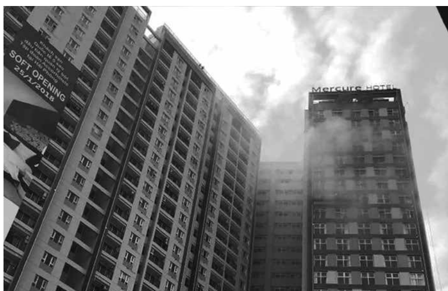
Quá trình đô thị hóa, hội nhập, xây dựng và phát triển kinh tế - xã hội tiếp tục được đẩy mạnh, việc đưa ra các biện pháp phòng ngừa cháy, nổ tại các công trường xây dựng là rất cần thiết và cấp bách
